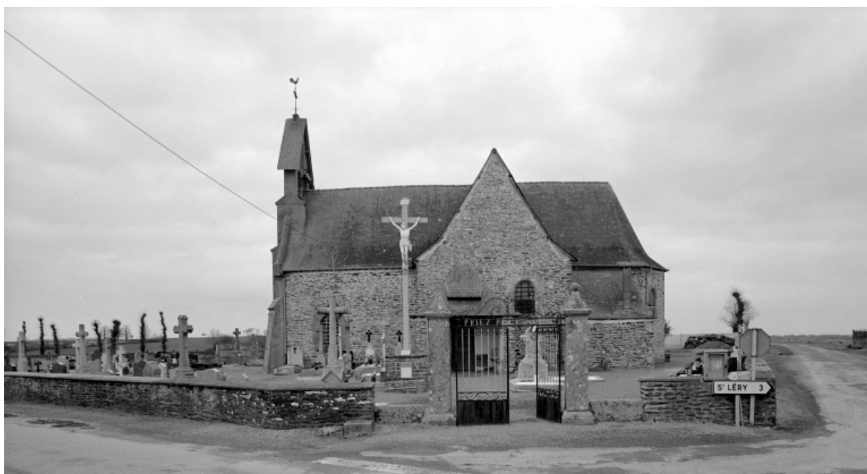
Elévation Sud : vue générale
