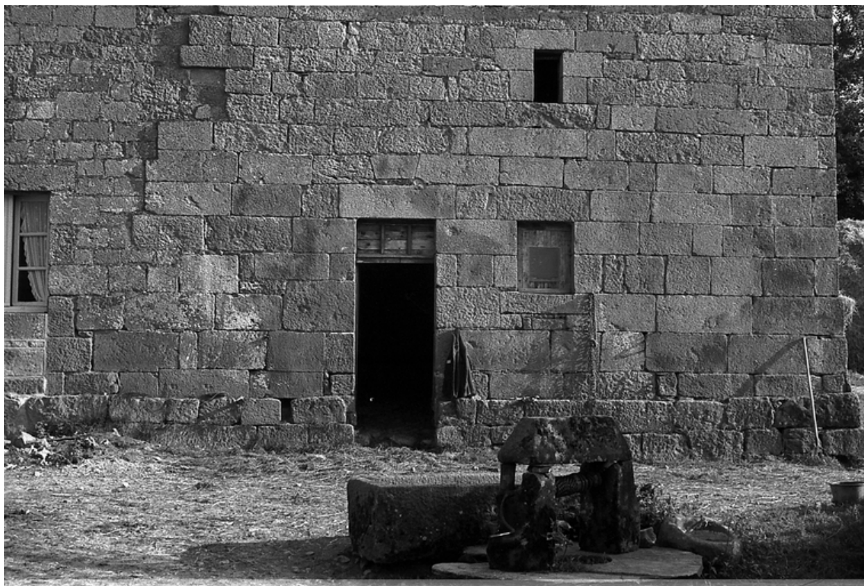
Façade nord : détail des ouvertures
