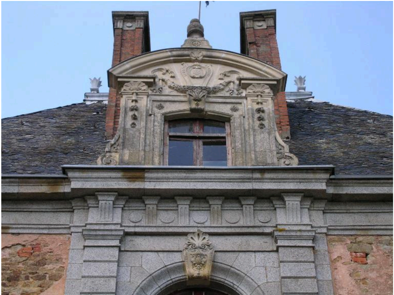
Détail d'une lucarne
