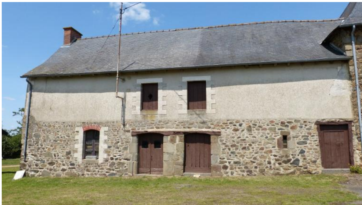
Vue générale sud, Ferme, Belême (Hédé-Bazouges)
