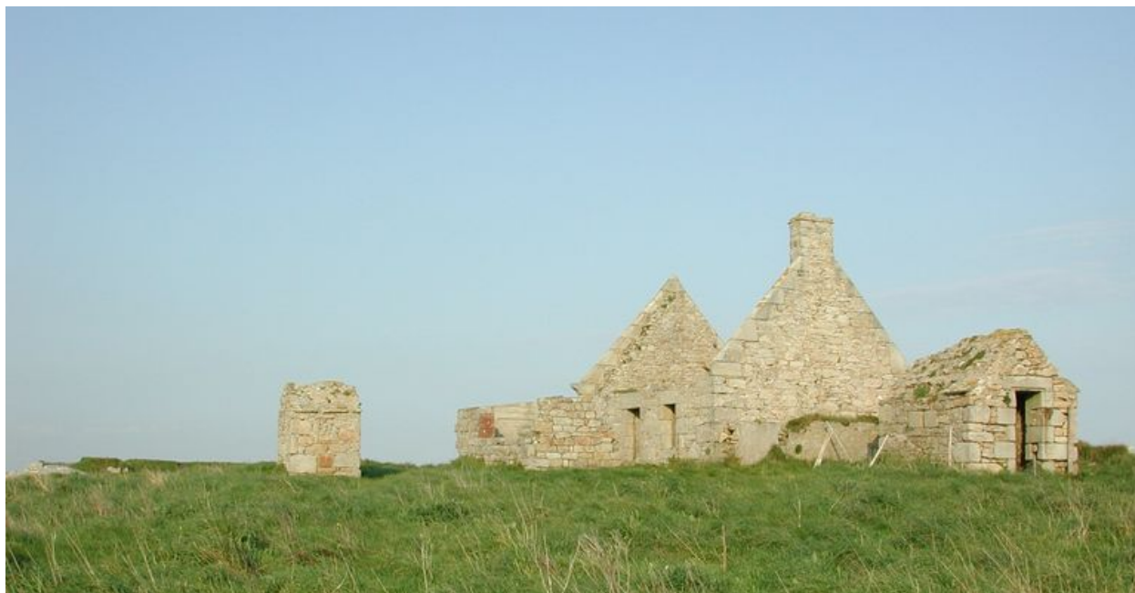
Santec : vue de l'ensemble fortifié de l'île de Sieck
