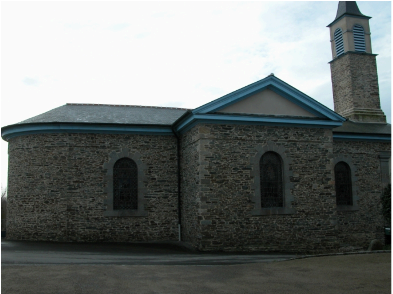
Eléation Nord : vue générale
