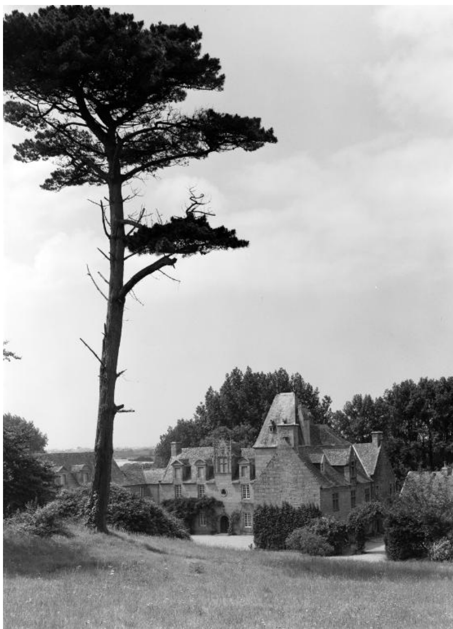
Vue de situation prise de l'est
