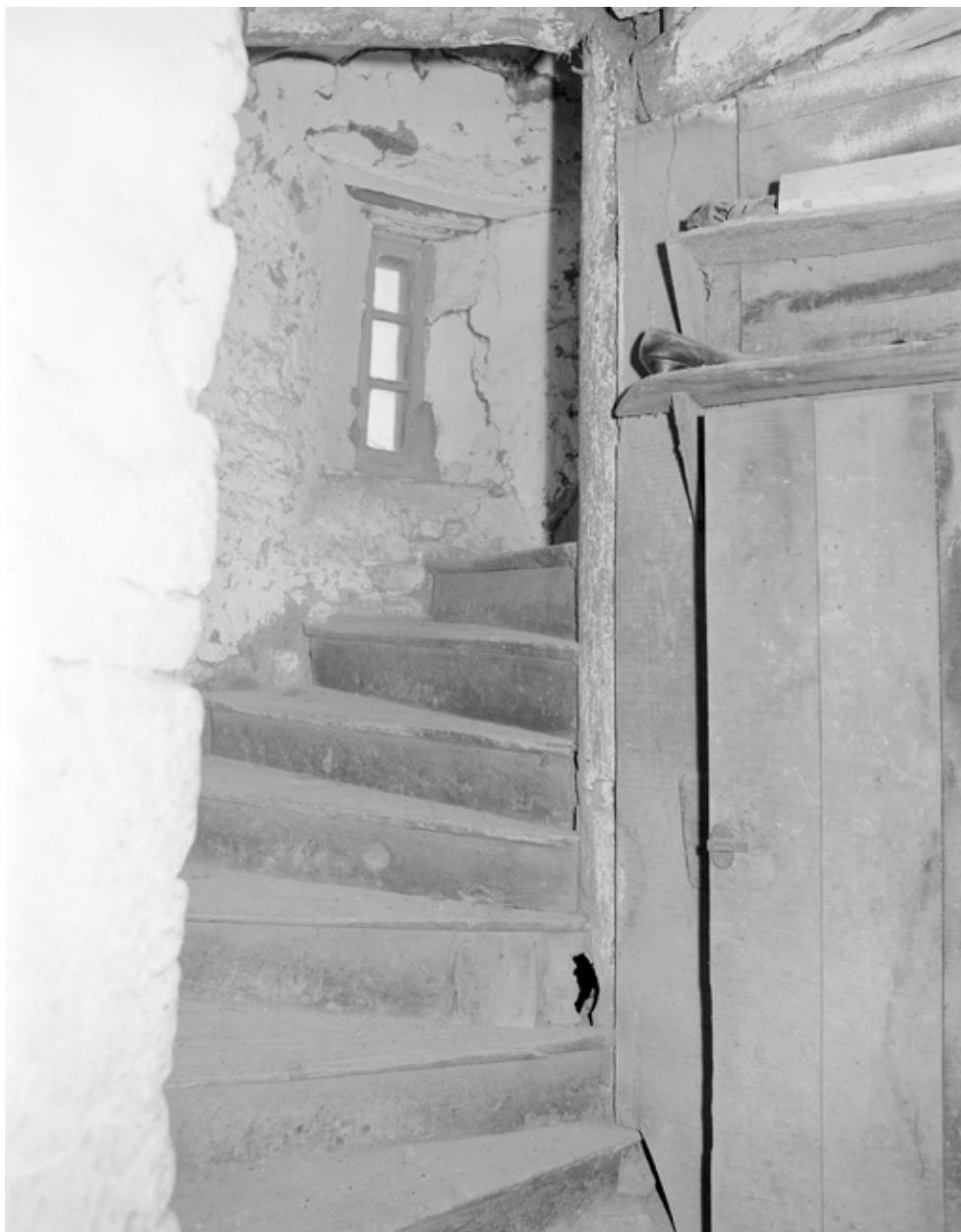
Vue de l'escalier prise du bas
