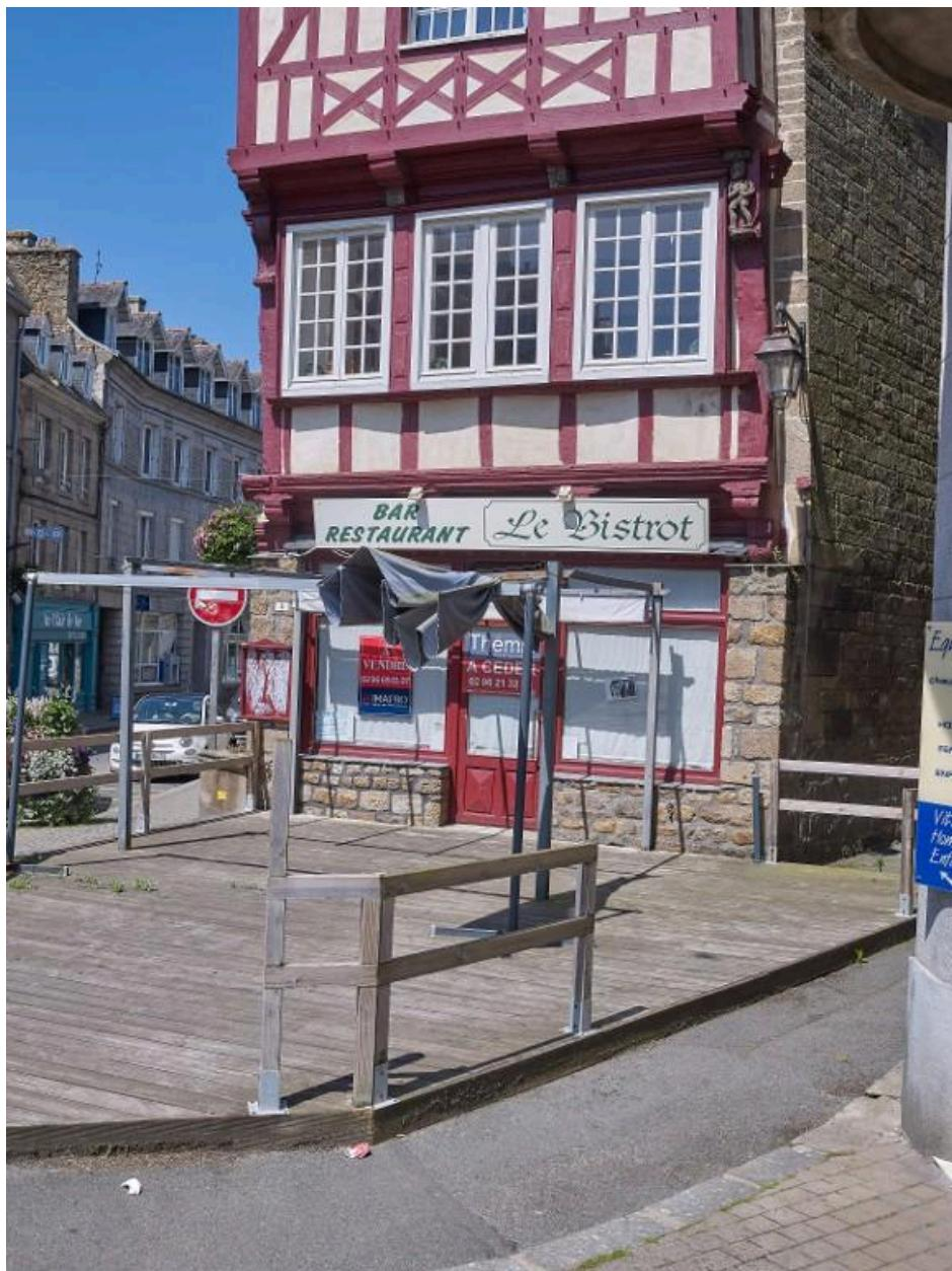
Le rez-de-chaussée a été remaçonné à l'aplomb de l'encorbellement.
