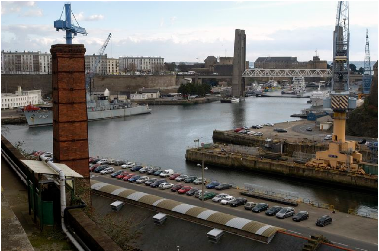
Vue de la Penfeld depuis les ateliers des Capucins (état en 2004)
