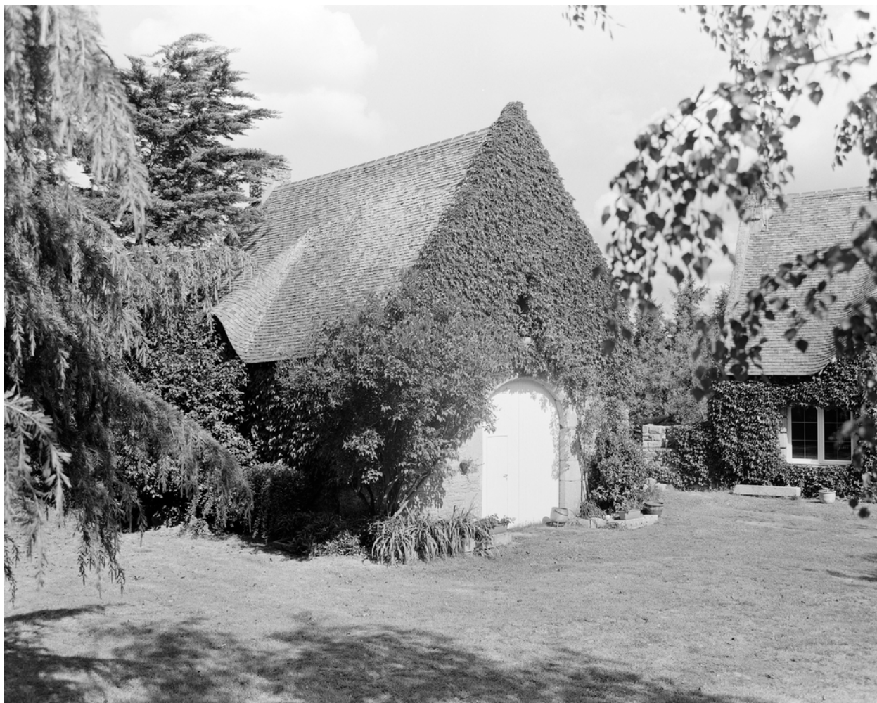
Kerloret. Grange, vue générale est.
