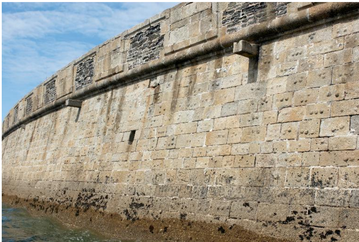
Plouzané : vue du fort du Mengant, batterie basse
