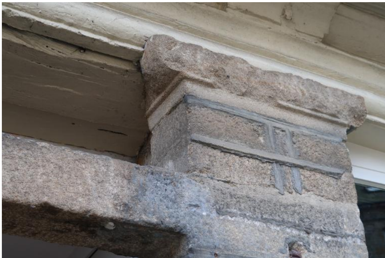
Détail d'une mouluration subsistant sur un pilier du rez-de-chaussée.
