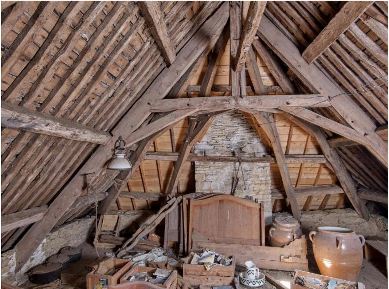
Logis. Charpente du comble. Partie est avec le conduit de cheminée et le plan à enrayure de la croupe
