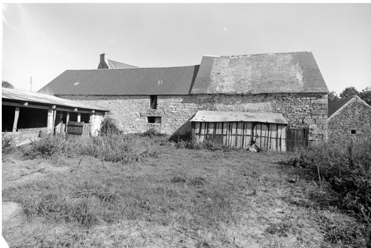
Vue générale des communs
