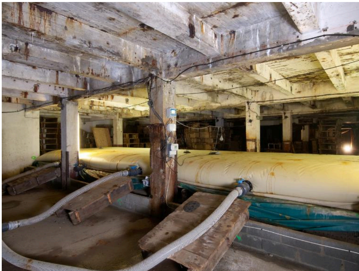
Zone frigorifique, étage 3 : réaffectée au stockage de l'eau par Véolia
