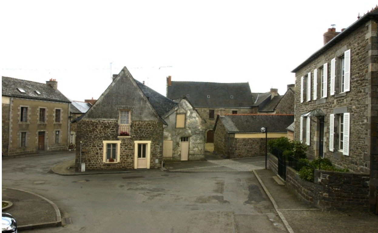
Vue de situation depuis la place André Ferré
