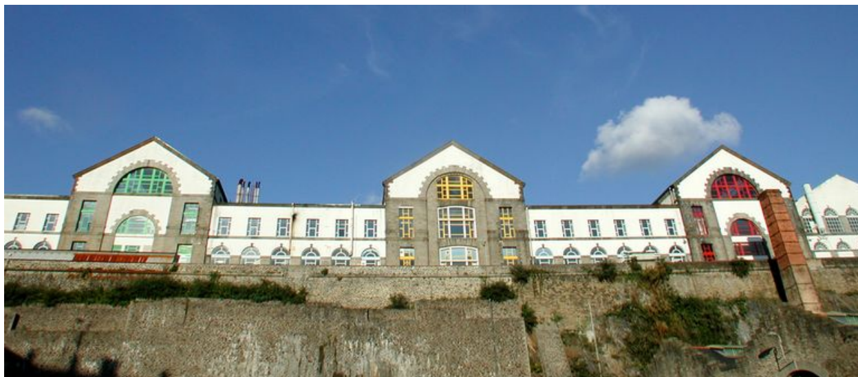
Vue des ateliers des Capucins (état en 2004)
