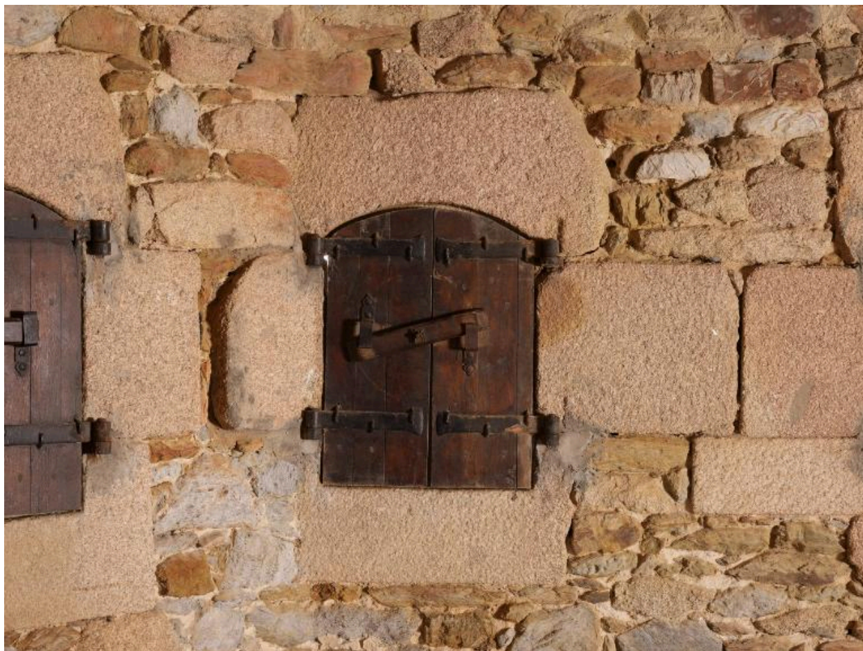
Camaret-sur-Mer : vue de la tour Vauban, troisième niveau, sabord fermé d'un créneau de fusillade
