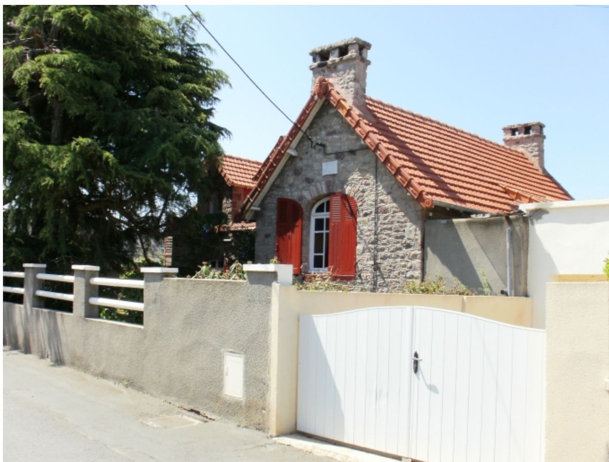
Vues des anciennes maisons construites par Bonne pour ses contremaîtres, avant 1914
