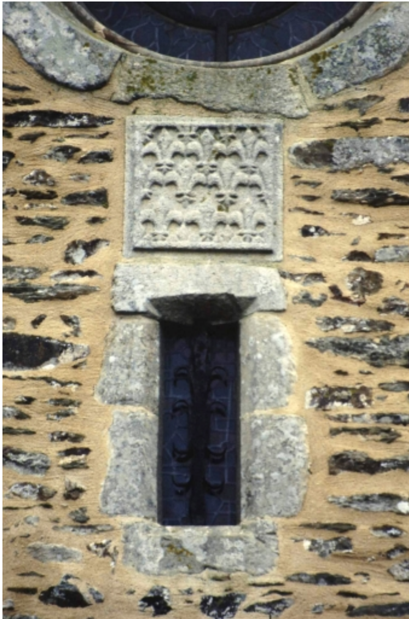
Elévation ouest : détail du jour et des armoiries, état en 1994
