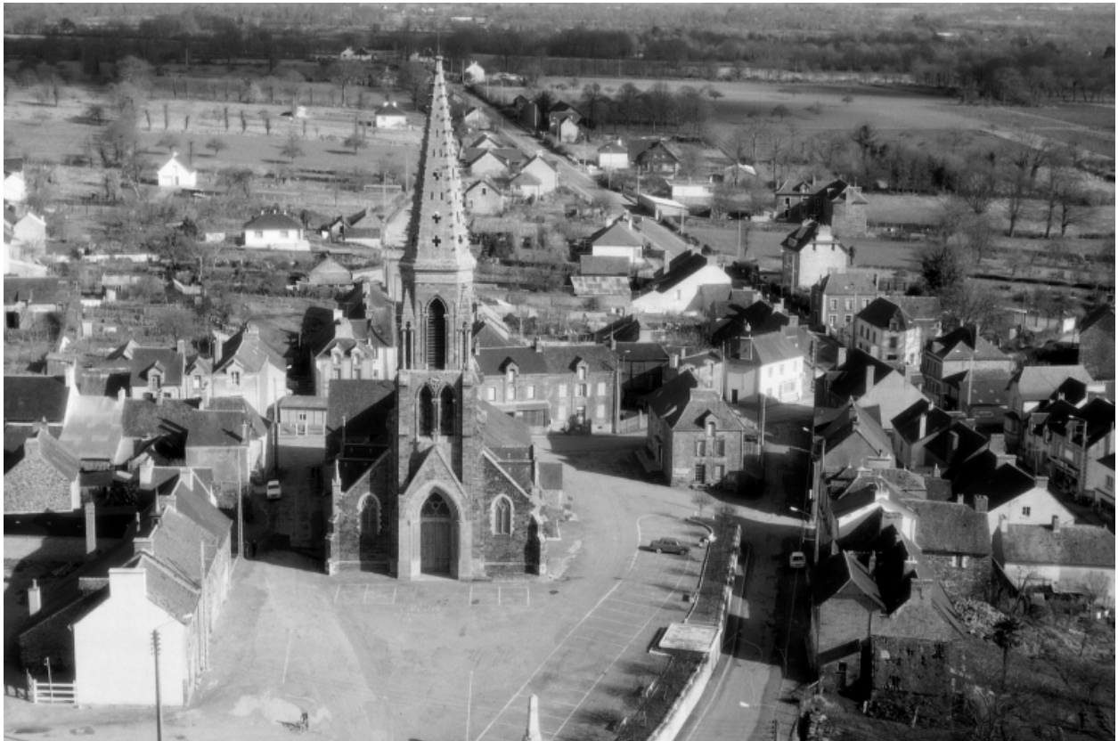
Elévation Ouest : vue aérienne.
