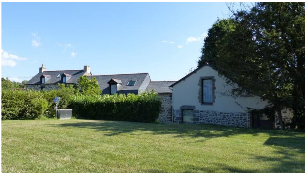
Vue générale nord
