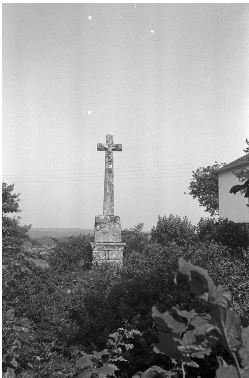
Vue générale de la face ouest
