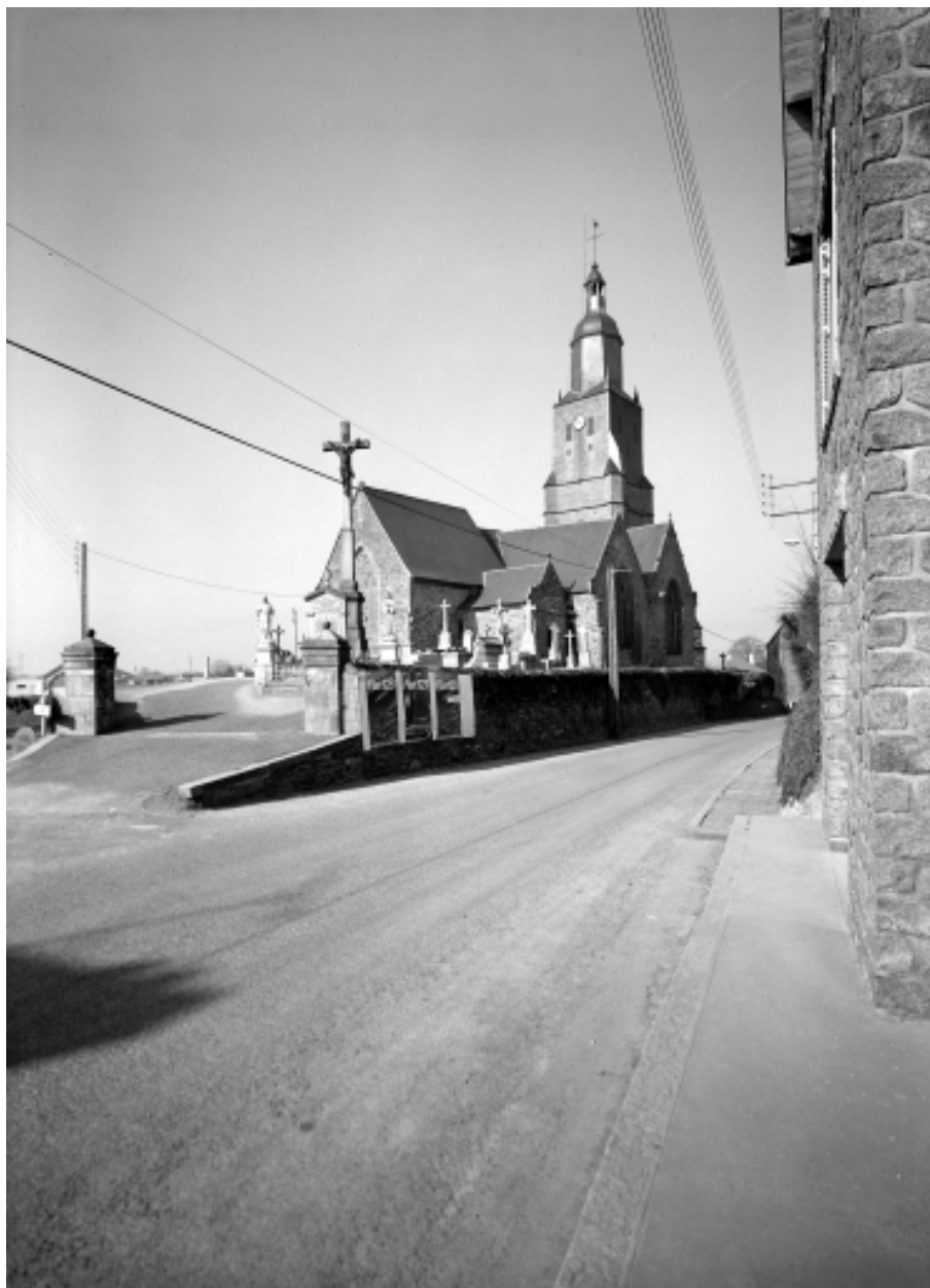
Elévation nord-est : vue générale
