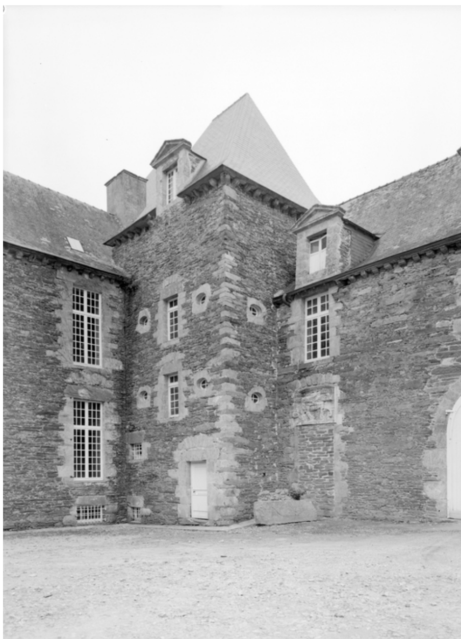
Logis, pavillon d'angle sud-ouest.
