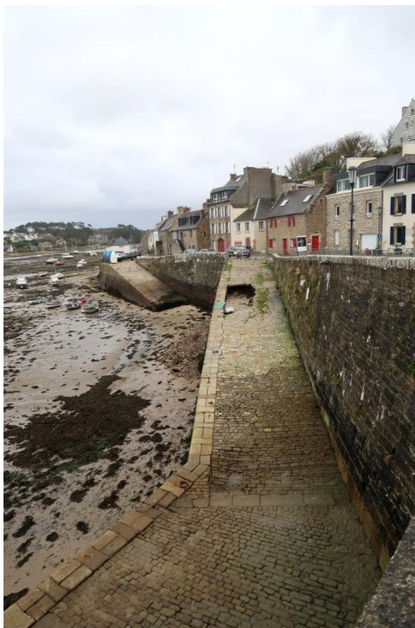
Cales du Drellac'h : situation par rapport au quai
