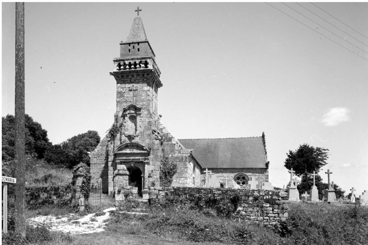
Elévation ouest : vue prise du sud ouest
