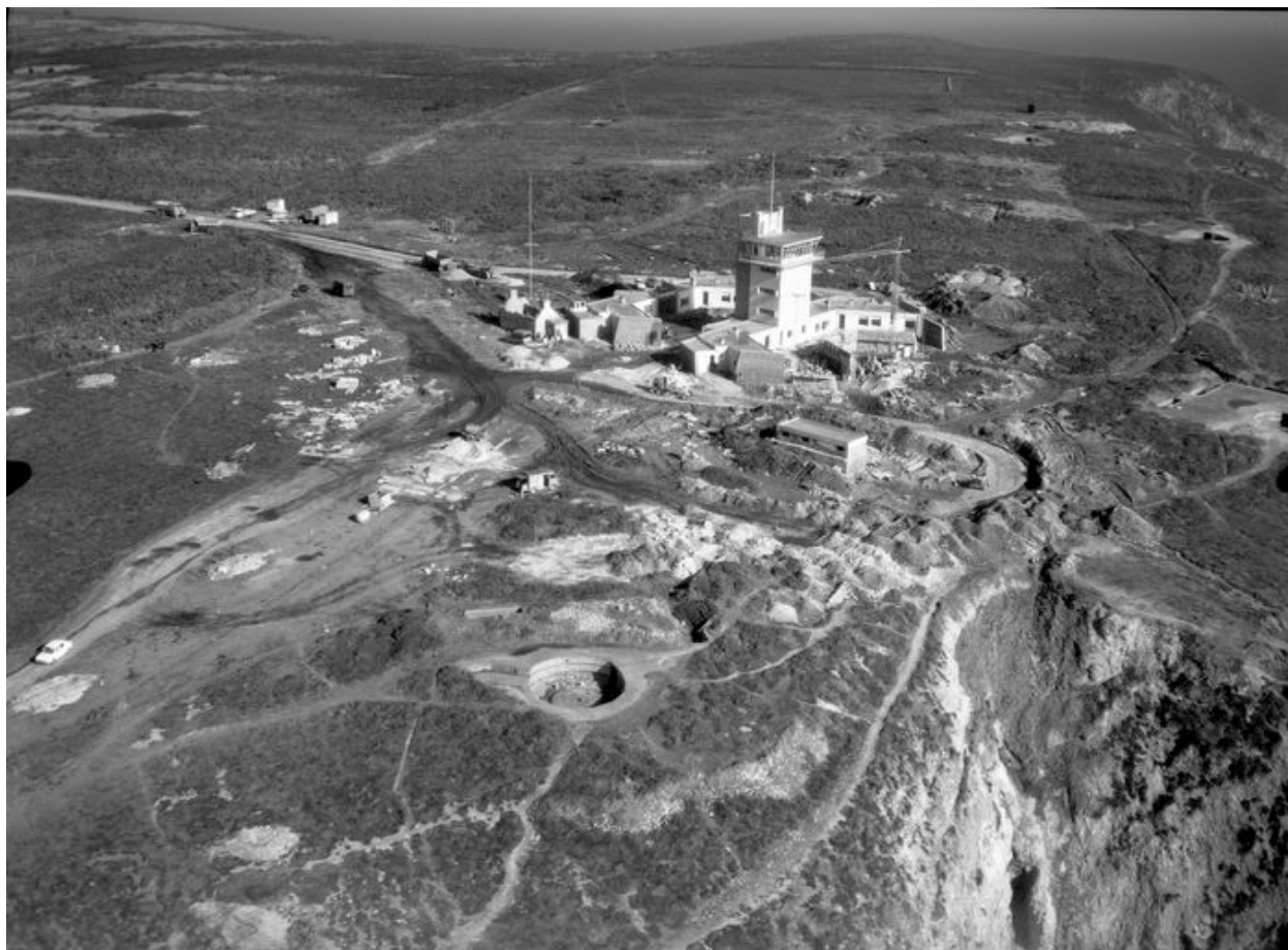
Vue aérienne oblique du Cap de la Chèvre en 1971 : sémaphore, cuves à canon de la batterie d'artillerie française, fouilles d'ouvrages allemands restés inachevés et cratères
