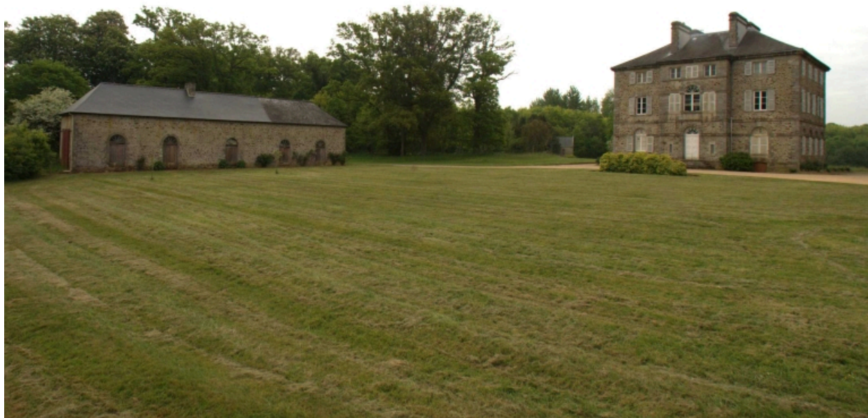
Château, façade nord et aile de communs
