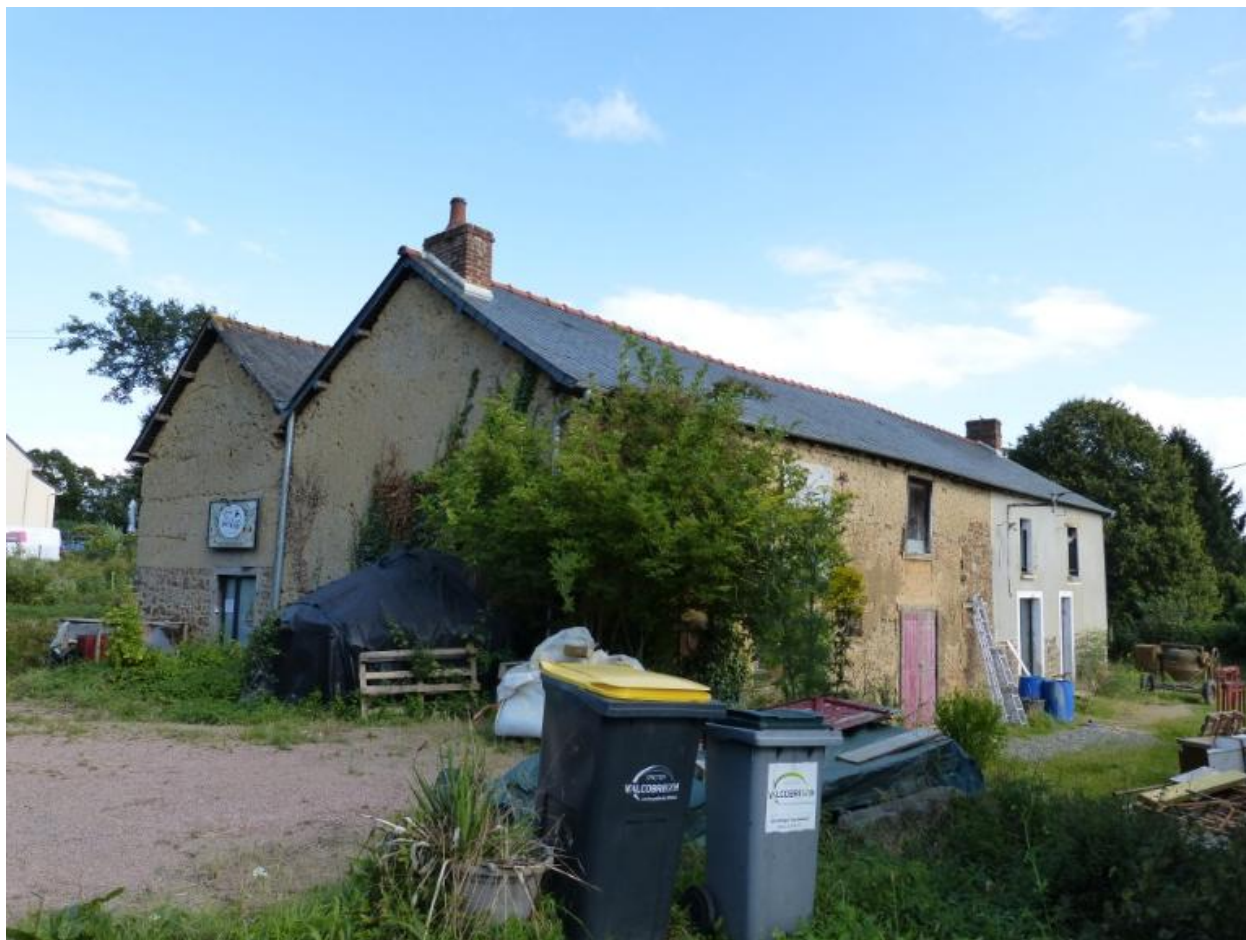
Vue générale nord ouest, 5 La Lande Es Gletz (Hédé-Bazouges)
