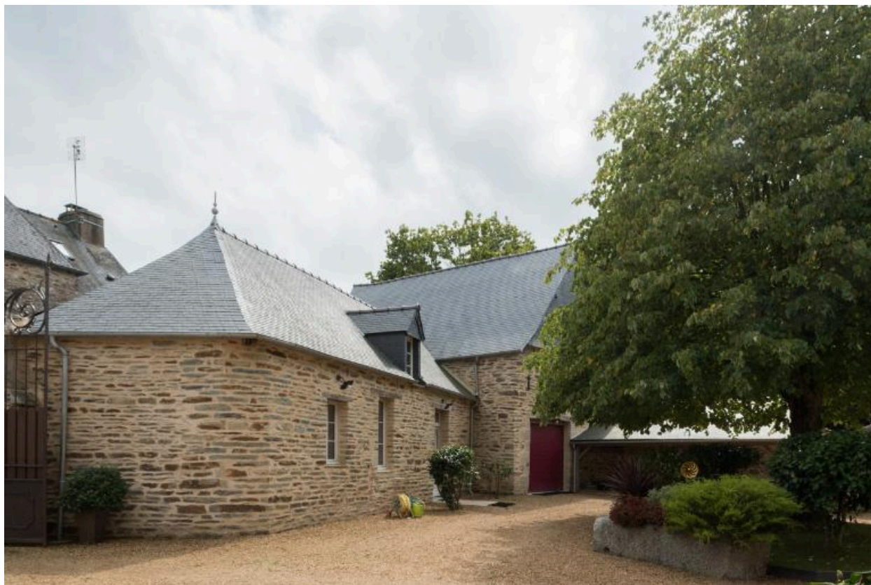
Dépendances au sud de la cour, vue générale nord-est
