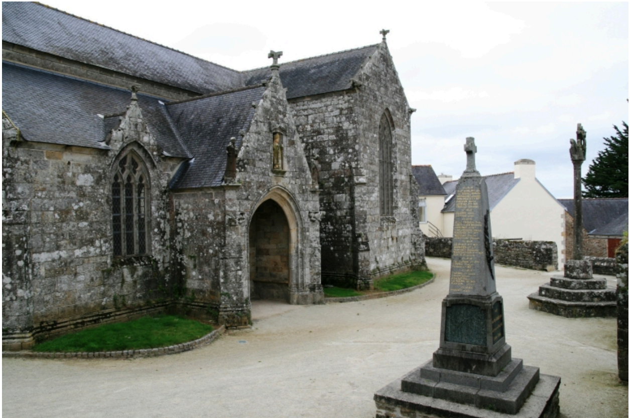
Quéménéven, église paroissiale Saint-Ouen : vue générale sud
