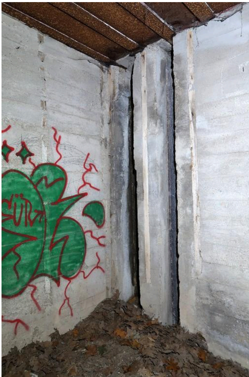
Vue intérieure : première salle, descente des câbles depuis la cuve du télémètre
