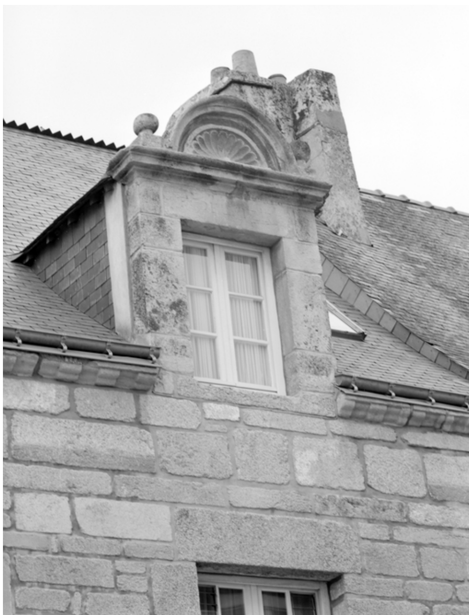
3 rue de l'Ancien Pont, détail, lucarne.
