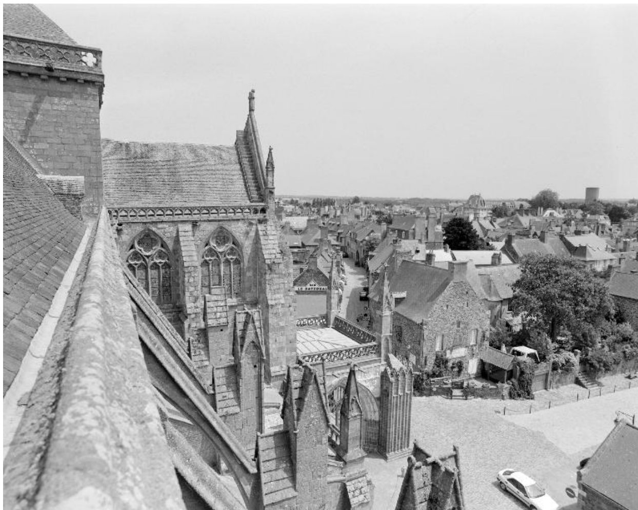
Elévation sud, face à la ville : vue partielle
