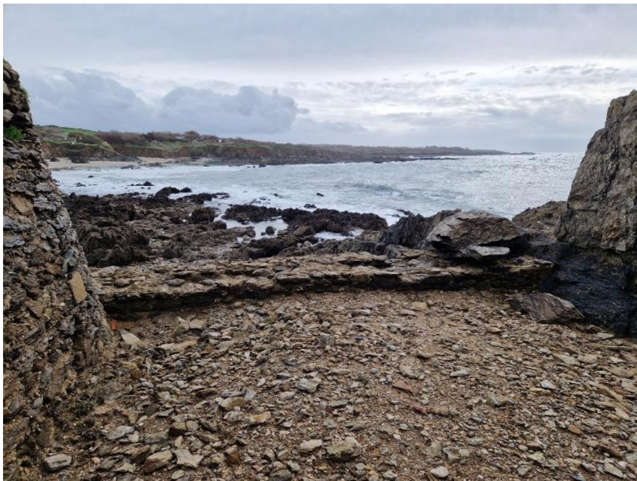
Vue du mur en maçonnerie de moellon implanté à l'est
