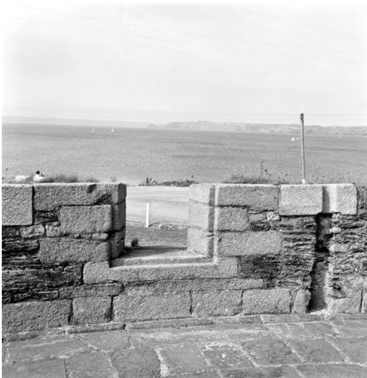
Vue d'une des embrasures de la batterie semi-circulaire de la tour Vauban en 1969
