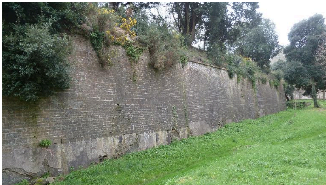
Le Palais, enceinte urbaine, bastion 21, face droite.
