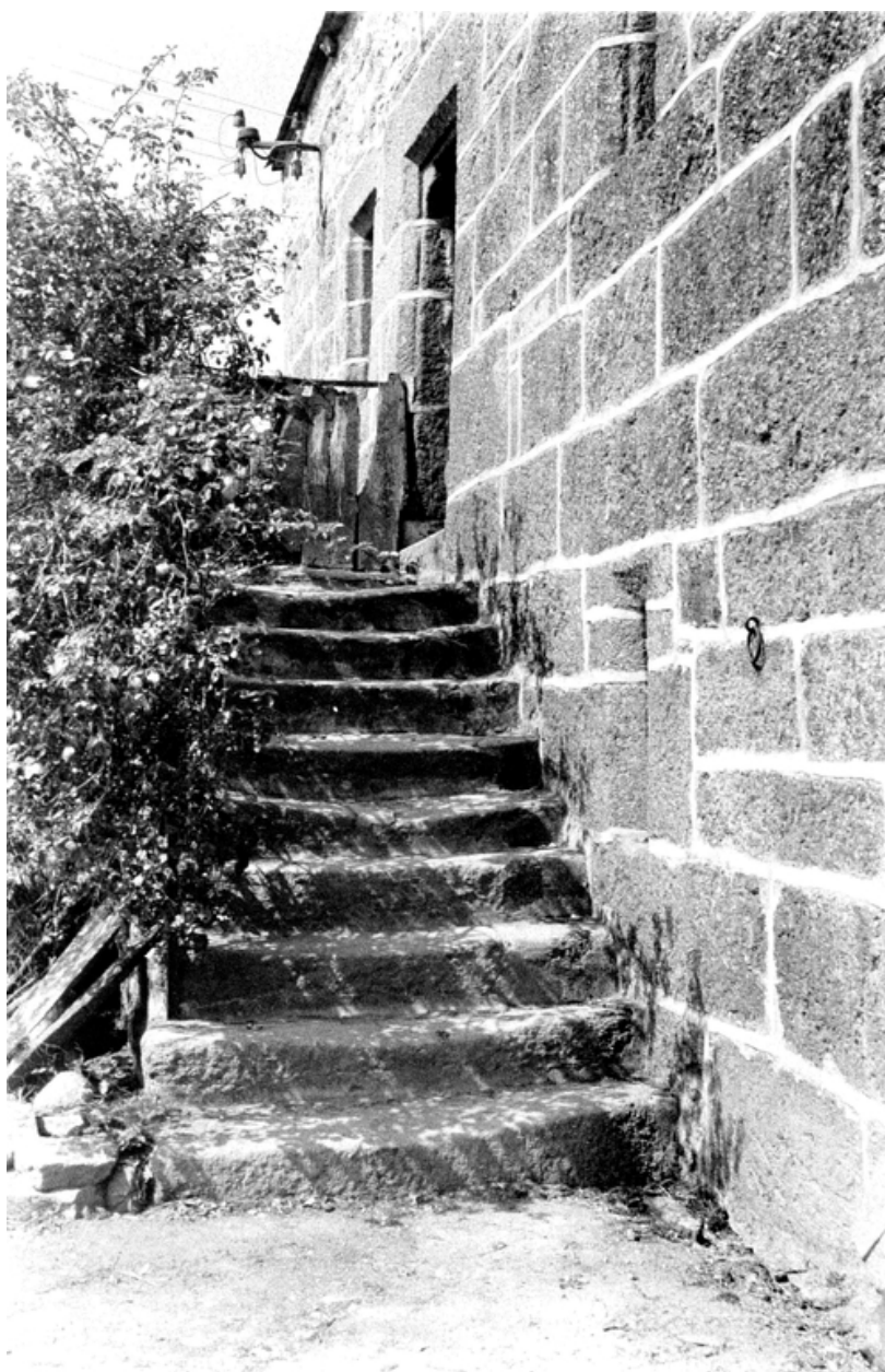
Façade sud : détail de l'escalier
