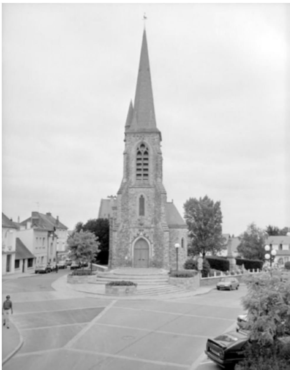
Vue générale ouest
