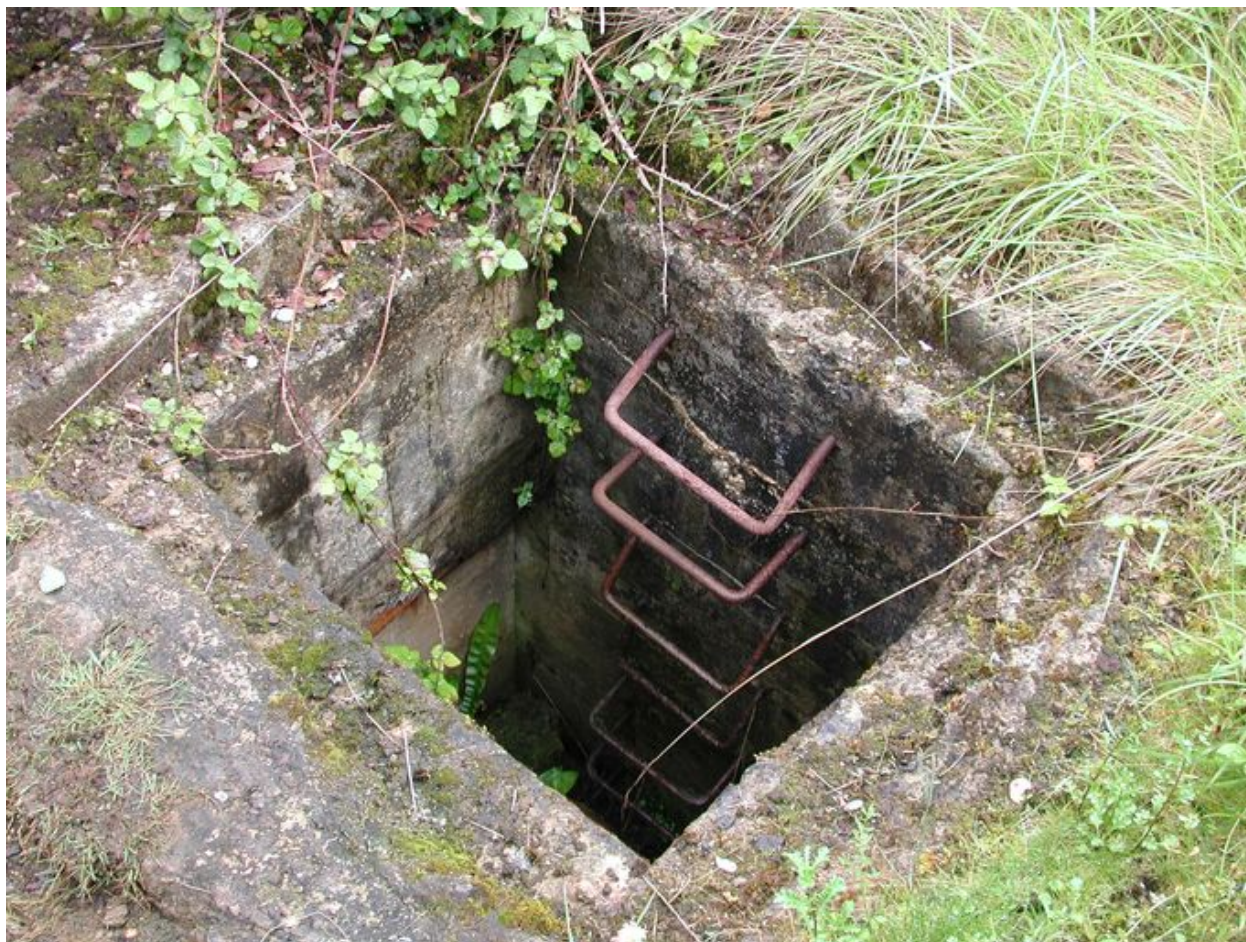
Vue de l'accès à la soute située sous le canon pour les douilles vides (état en 2002)
