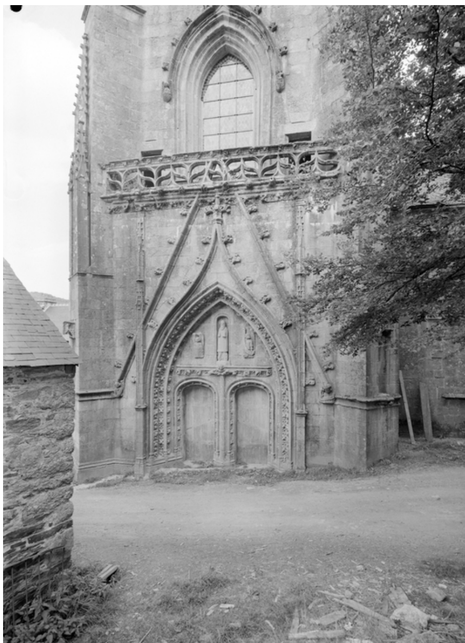
Portail ouest, vue générale
