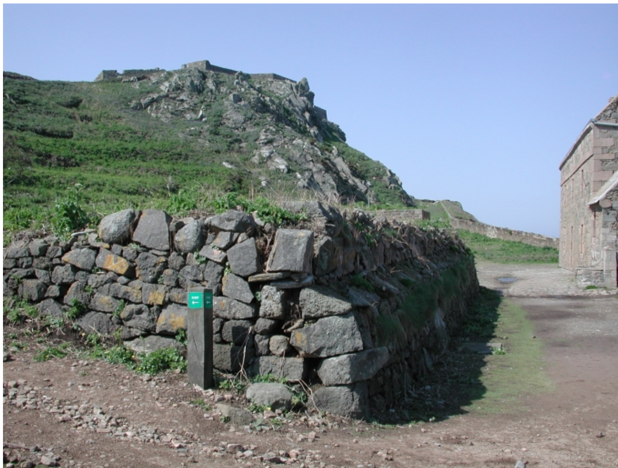
Mur de soutènement du jardin en terrasse au sud de la citadelle
