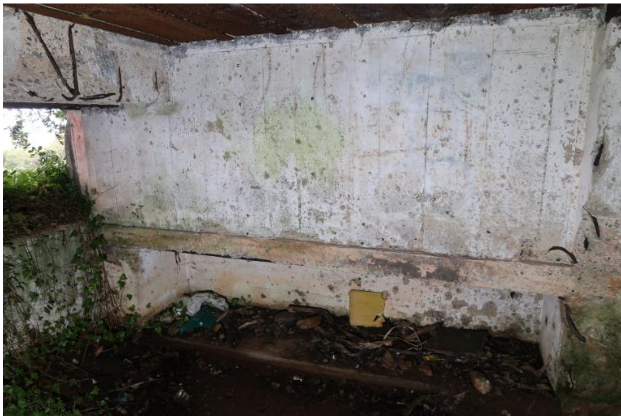
Vue de la chambre de tir : mur ouest (état en 2021). Au ras du sol, longue niche murale pour le stockage des munitions
