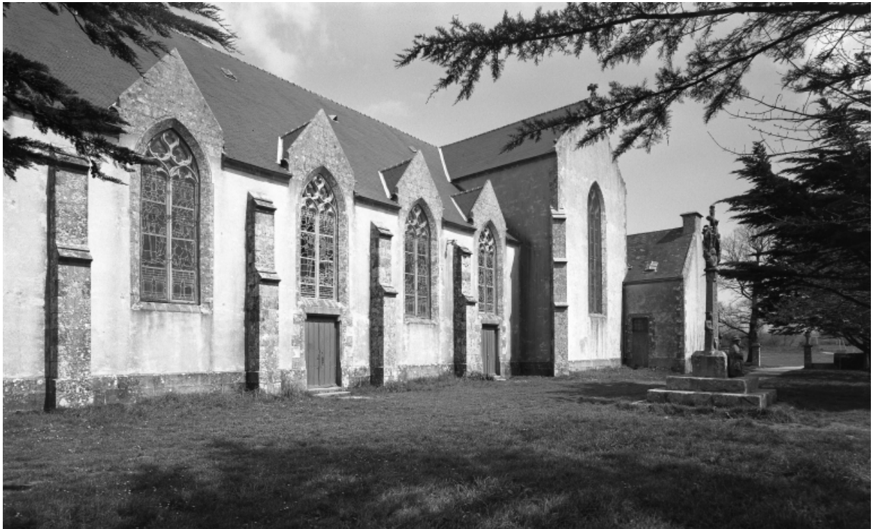
Plonévez-Porzay, chapelle Sainte-Anne-La-Palud : façade sud, état en 1972
