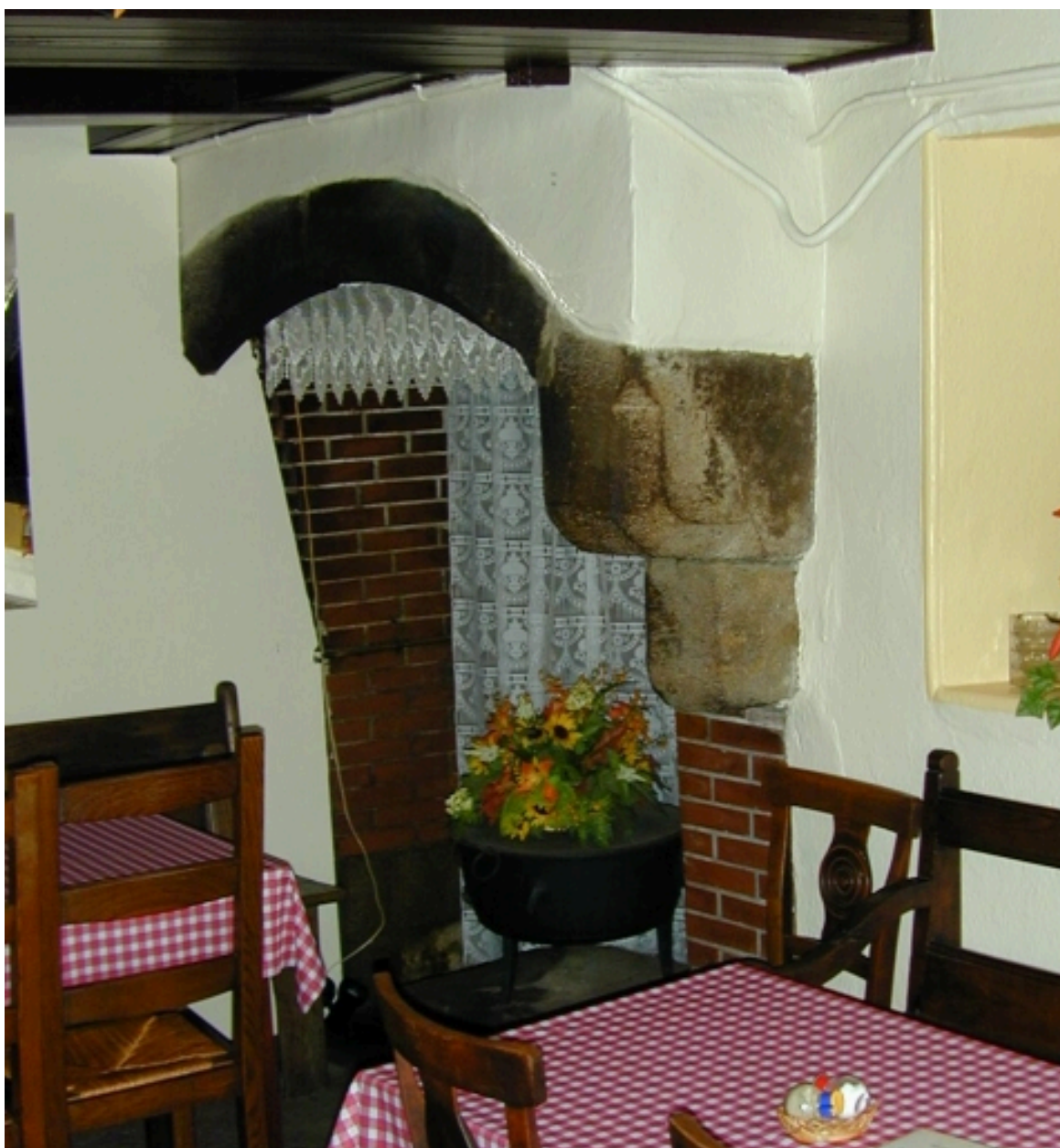
Mur ouest, cheminée
