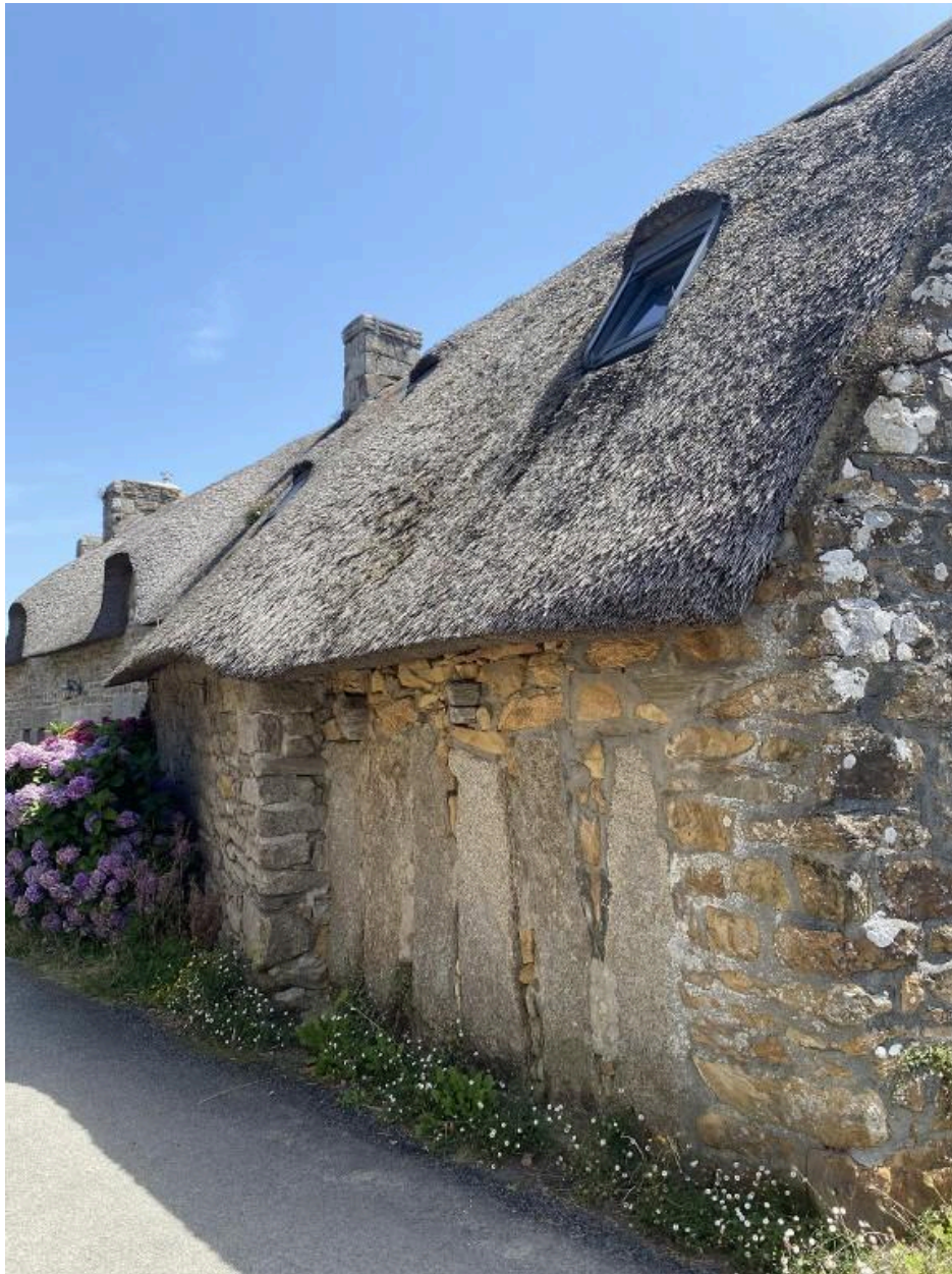
Vue de détail de l'élévation nord.
