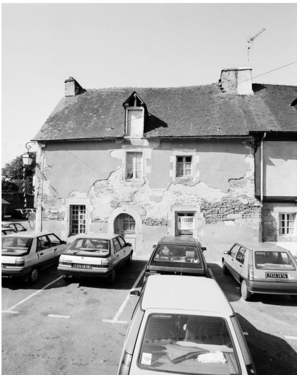
Maison de commerçant : élévation est (état en 1992)
