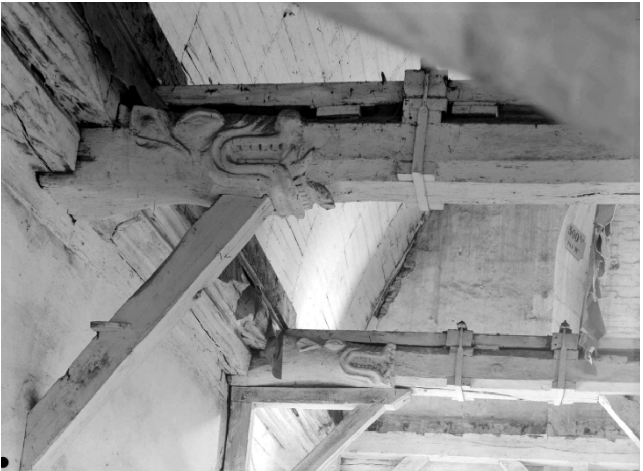
Bras sud du transept : détail des engoulants
